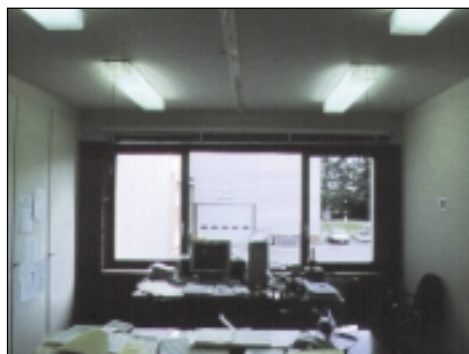
Figuur 58: Slechte lichtprestaties met opaline afschermkappen (PROBE, vóór renovatie).
