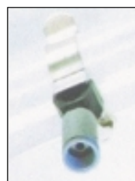
Figuur 64: Daglichtsensor op verlichtingstoestel.
