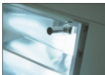
Figuur 66: Een kleine sensor in het verlichtingstoestel meet de luminantie op het werkoppervlak en regelt het vermogen van het kunstlicht naar gelang van het beschikbare daglicht.
