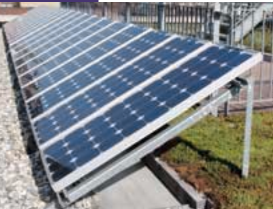
1. Antwerpen, België. Ecohuis (IZEN), 2. Braunschweig, Duitsland. Appartementen (Alwitra). 3. Mechelen, België. Kantoorgebouw (Solar Technics). 4. Braunschweig, Duitsland. Appartementen (Alwitra). 5. Rotterdam, Nederland. Gemeentearchief (SenterNovem, Hans Pattist).
